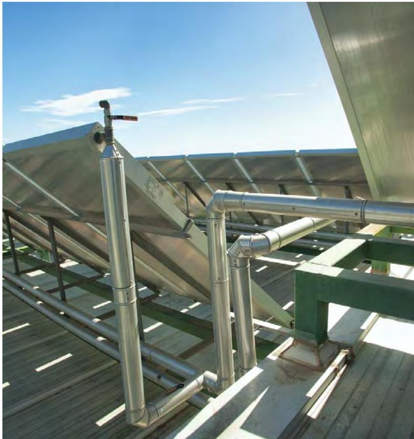
Instalación de energía solar para producción de agua caliente sanitaria en Hospital Torrecárdenas de Almería compuesta por 270 captadores solares planos SOLARIS CP-1 para producción de ACS.
